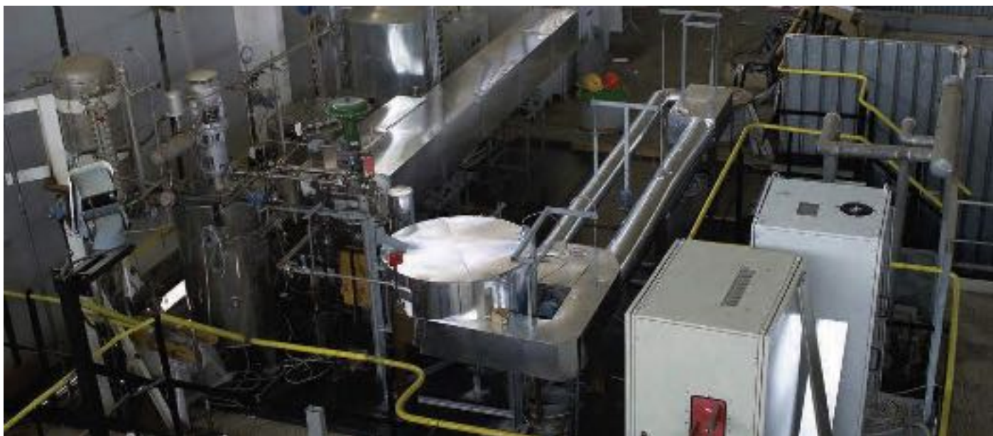
Impianto sperimentale MOSE
