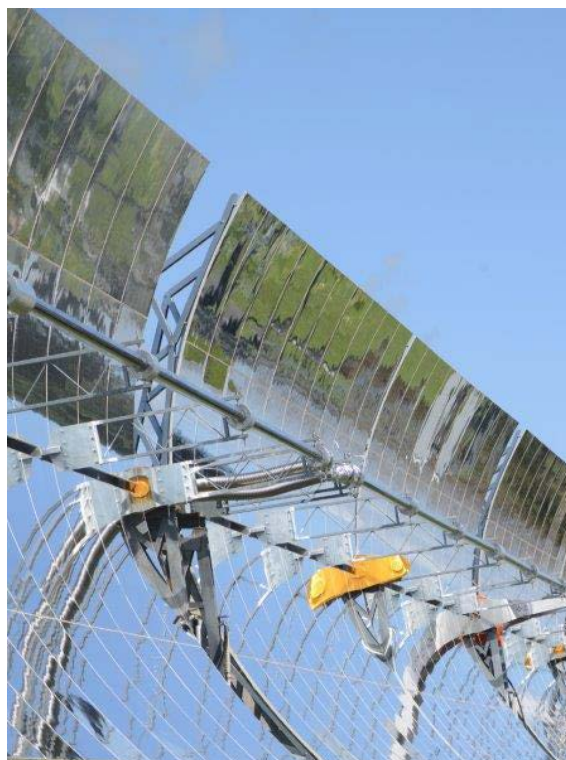
Particolare del collettore a Sali fusi
