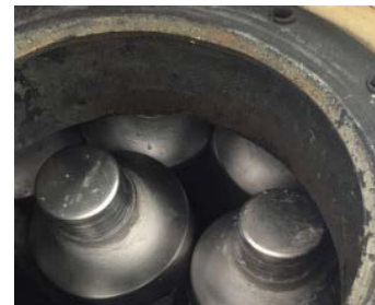
Moduli cilindrici contenenti PCM
