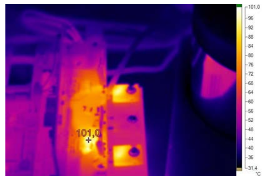
Esempi dell'attività sperimentale di caratterizzazione di convertitori DC-AC
