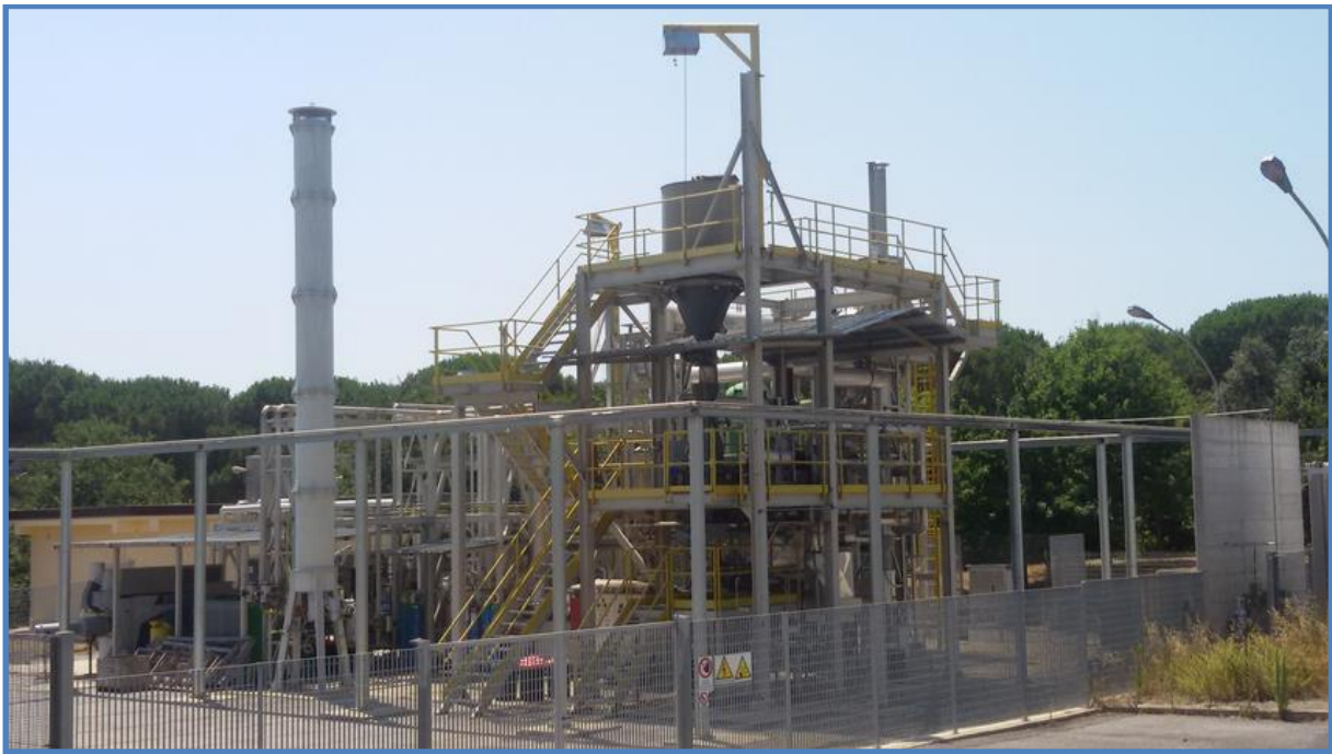
Figura 2 Vista d'insieme dell'Infrastruttura di Ricerca ZECOMIX
