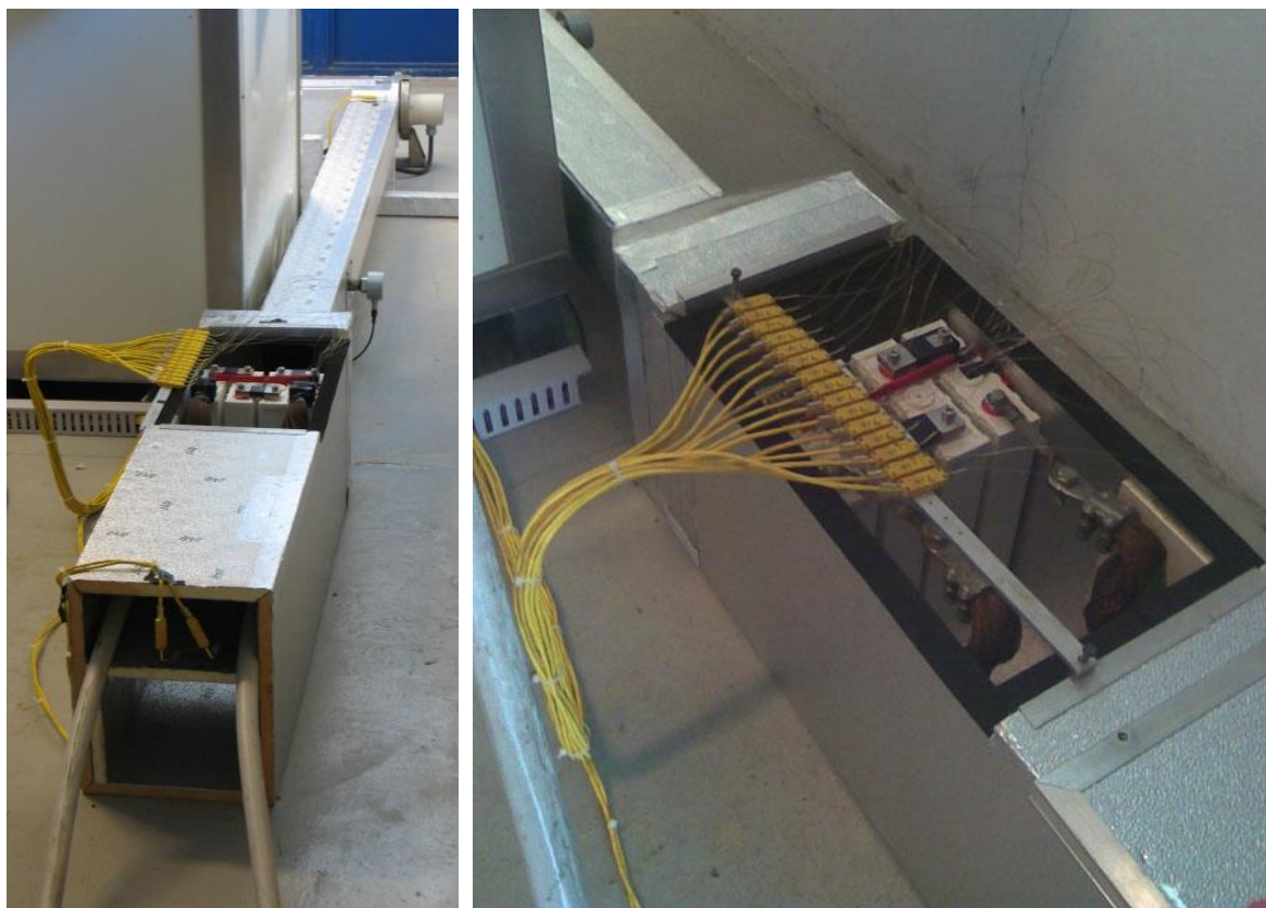
Figura 1 Impianto BACO e disposizione delle batterie all'interno della sezione di prova
