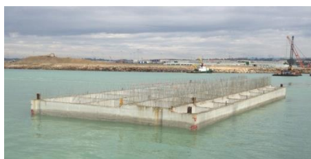
Dispositivo U-OWC in costruzione nella nuova darsena di Civitavecchia
